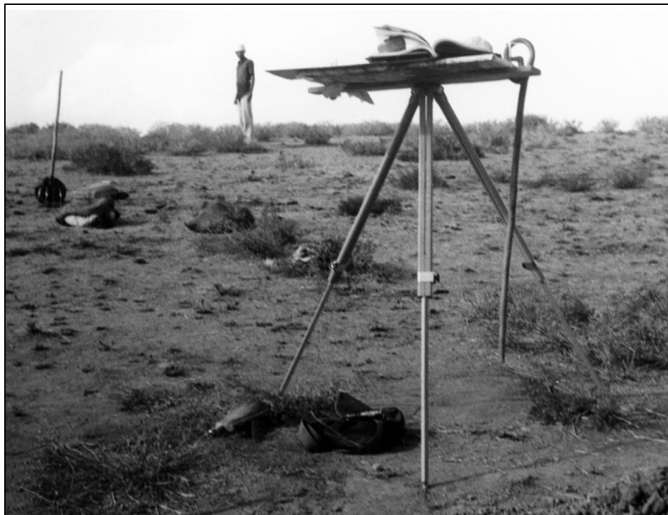
شکل ۳. میز تراز که در شبکه‌بندی سطح دینخواه تپه در فصل ۱۹۶۶ استفاده شده است.
